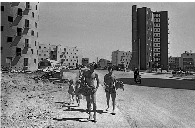
Logements en construction à Bobigny, banlieue de Paris, pour Réalités , 1959.
